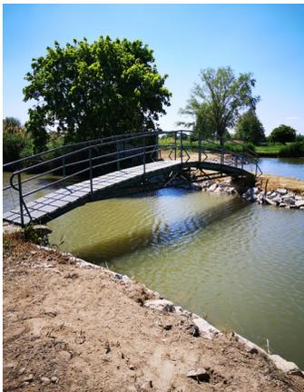
L'enrochement des berges des étangs a continué en mai 2020. Cet enrochement permet la sécurisation des berges. Une stabilisation a également été faite au niveau du pont pour lutter contre l'affaissement de terrain.
