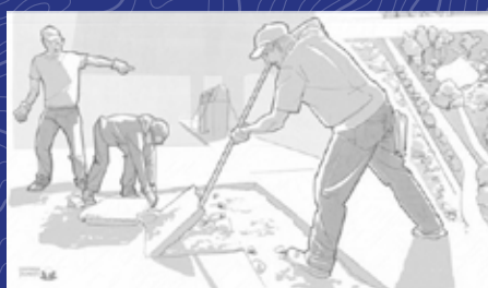
Technique de désimperméabilisation utilisée au niveau du Préau.
