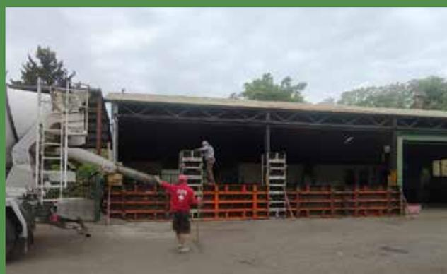
Dalle béton pour l'installation du récupérateur d'eau pluviale
