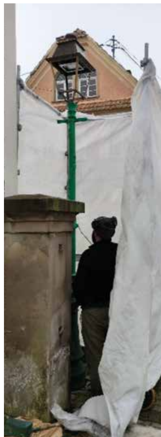
Remise en peinture des candélabres de la rue du Moulin
