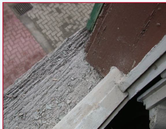
Cloison après démolition remplissage
